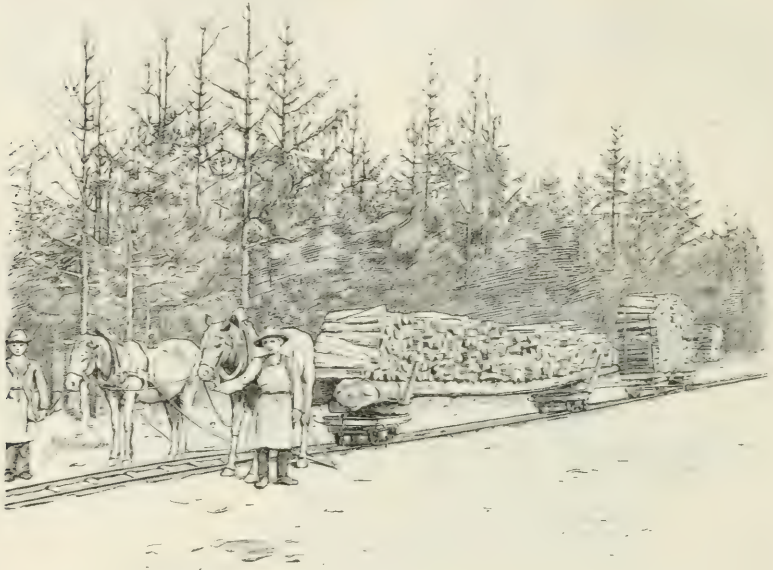
Fig. 182. Brennholztransport auf Doppelwagen mit Langstämmen.
