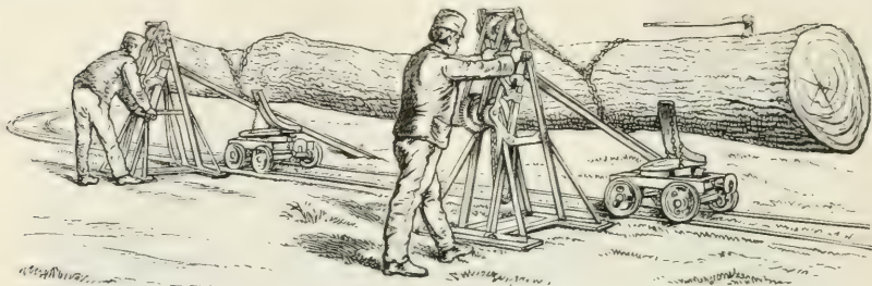
Fig. 187. Verladen mittels des Ladebaumes.
